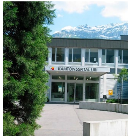
L'hôpital cantonal d'Uri est un hôpital de soins aigus qui dispose d'un service complémentaire pour les patientes et les patients nécessitant des soins à long terme. Il offre une base élargie de soins à environ 35'000 habitants.
